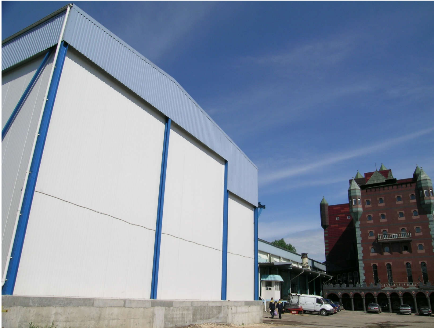
МОРСКОЙ ЗАМОК. Низкотемпературный склад (-25 С). Москва
