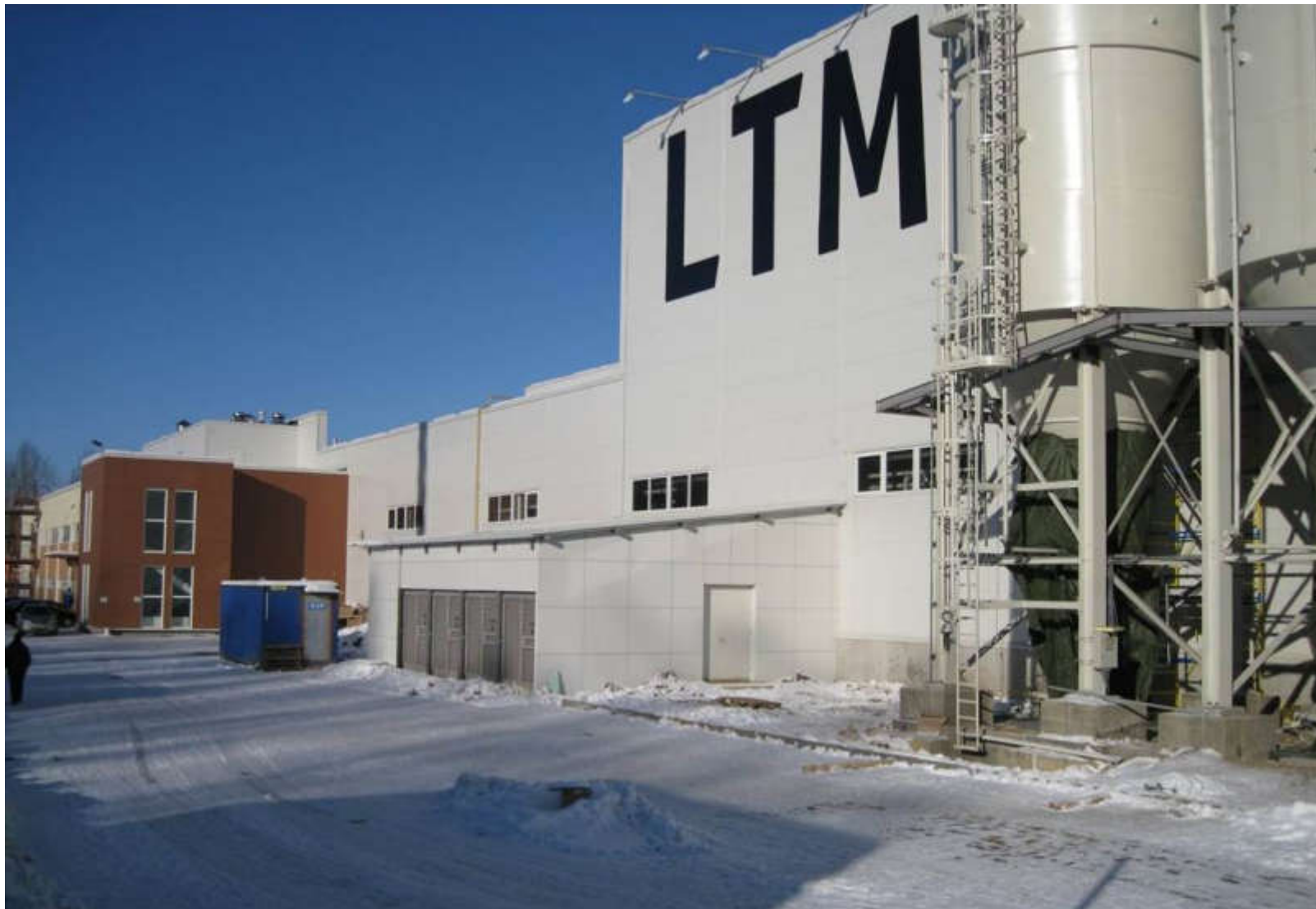
ЛТМ. Завод по производству фиброцементных плит. Обнинск, Калужская область
