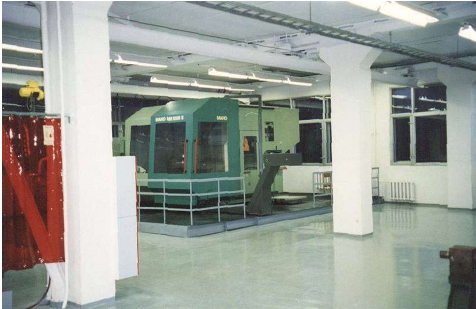
ЮНАЙТИД ТЕКНОЛОДЖИС. Завод по производству систем кондиционирования. Москва
