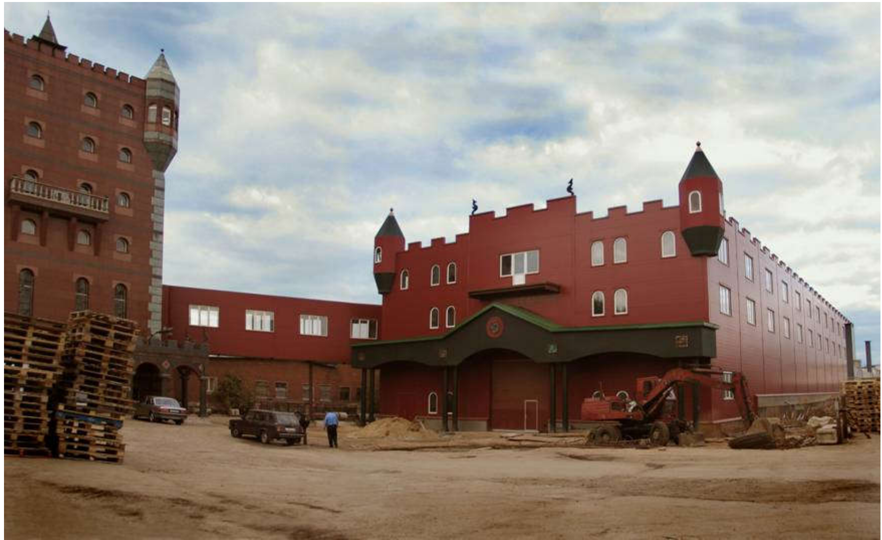
МОРСКОЙ ЗАМОК. Завод по производству рыбных полуфабрикатов. Москва
